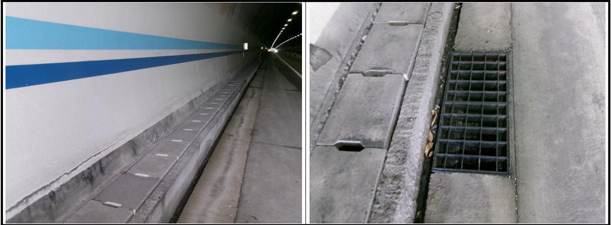
【사진 4.3.9】 공동구 및 배수시설 전경
