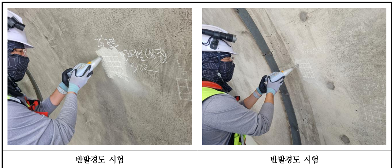
【사진 4.4.2】 반발경도시험 현장사진
