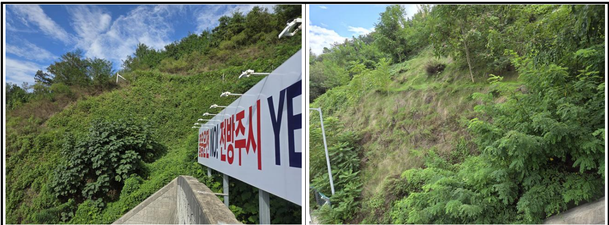
【사진 4.3.21】 사면 전경
