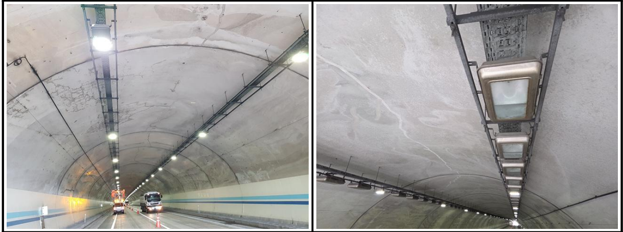
【사진 4.3.1】 라이닝 천단부 전경
