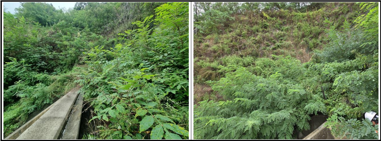
【사진 4.3.7】 사면 전경
