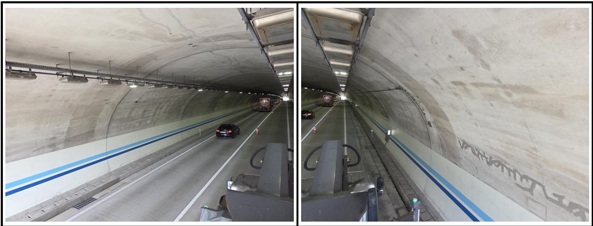
【사진 4.3.17】 라이닝 측벽부 전경
