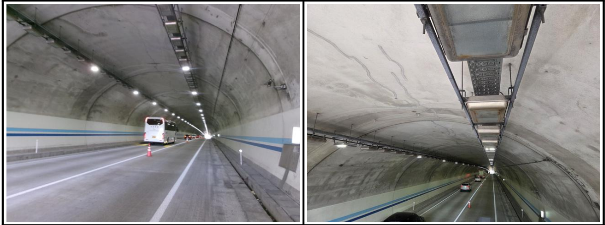
【사진 4.3.15】 라이닝 천단부 전경
