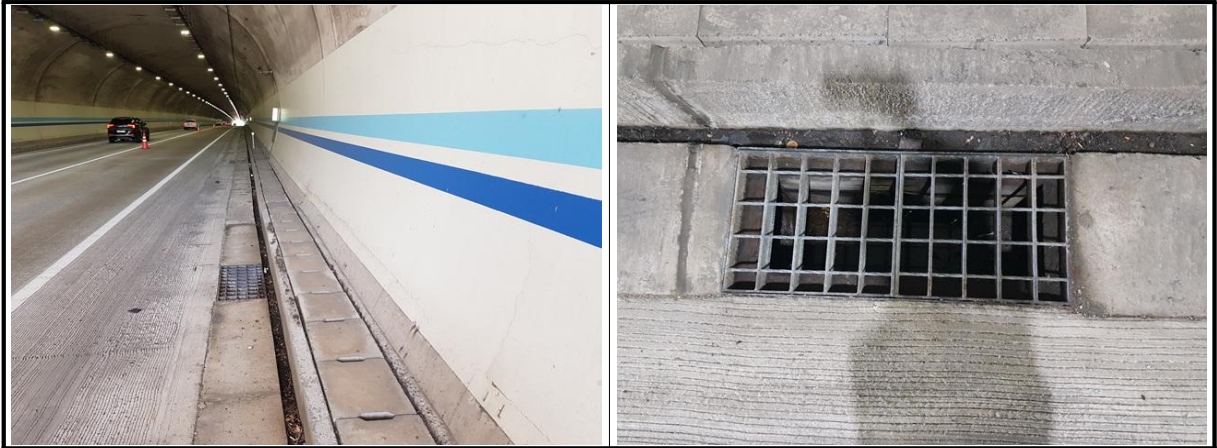
【사진 4.3.23】 공동구 및 배수시설 전경
