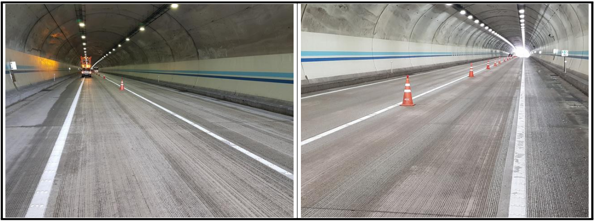
【사진 4.3.11】 포장부 전경
