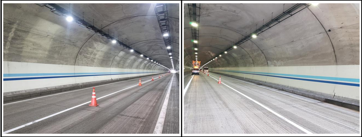
【사진 4.3.3】 라이닝 측벽부 전경
