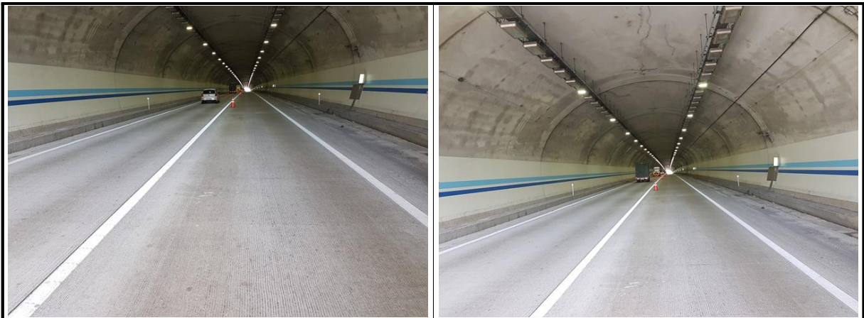
【사진 4.3.25】 포장부 전경
