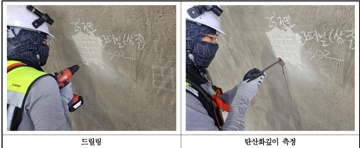
【사진 4.4.3】 탄산화 깊이 측정 현장사진
