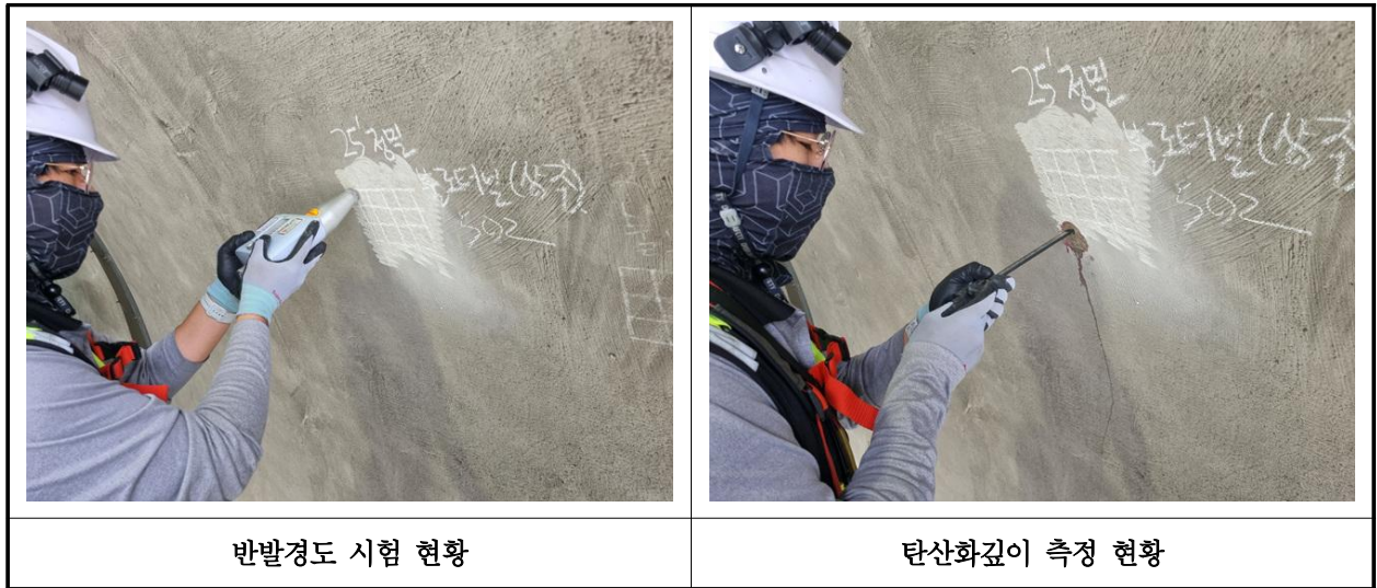
【사진 4.4.1】 콘크리트 내구성조사 현황
